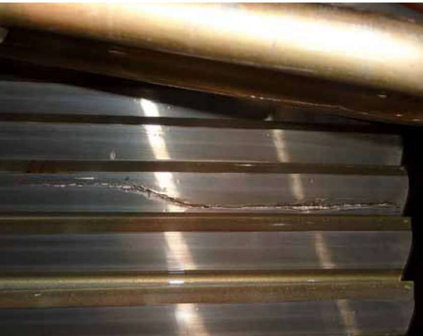
Der Abbruch dieses Zahns auf 75 Prozent der Breite stand kurz bevor. Das Condition-Monitoring-System hatte das Problem nicht erkannt.
